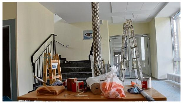
Noch wird gearbeitet im Inneren der Haupt- und Realschule. Eine neue Deckenverkleidung wurde bereits angebracht, die Malerarbeiten werden bald fertig sein. Die neue Beleuchtung wird in den nächsten Tagen installiert. Björn Dieckmann
